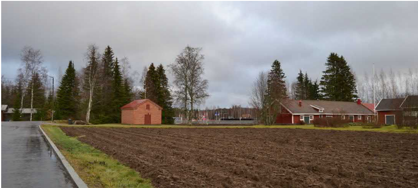
Kuva: Alue 3. Loimolan tilan rakennukset muodostavat maisemallisesti merkittävän kokonaisuuden peltojen ja Pyhäjärventien väliin. Tiilinen makasiini sijaitsee keskeisellä paikalla Veijanmäenkadun ja Loimolankadun risteyksessä. Tilakeskus kuvattuna Loimolankadulta.
